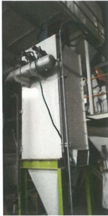
输送机袋式除尘器
