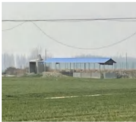
地块北部废弃的沼气池
